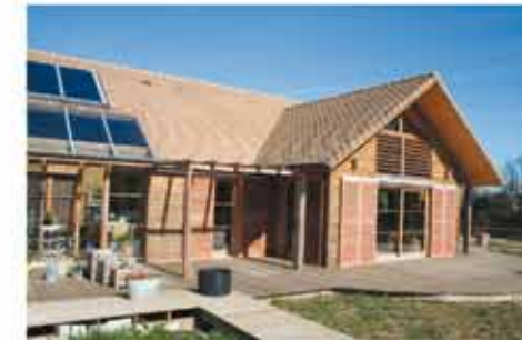
archi.: Y. Serres - ent.: D. Place
