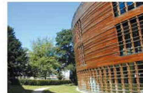
Médiathèque d'Evreux - archi.: P. Chemetov & B. Huldobro - ent.: Barbaray & J.P.V.
